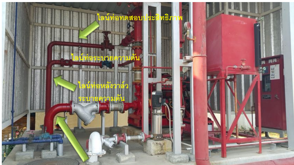
ควรทำจุดยกหัวสำหรับยกท่อทางดูดของปั้มน้ำขึ้นมาซ่อม
