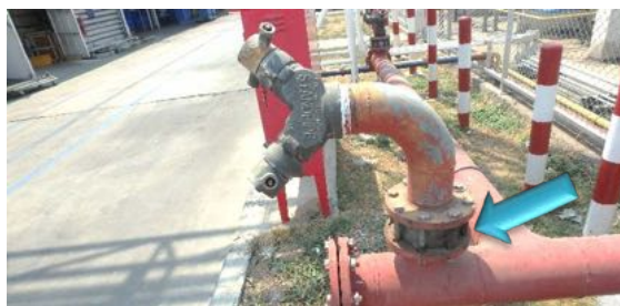
Check Valve ของหัวรับน้ำดับเพลิงชำรุดปิดน้ำไม่อยู่ทำให้น้ำรั่ว
