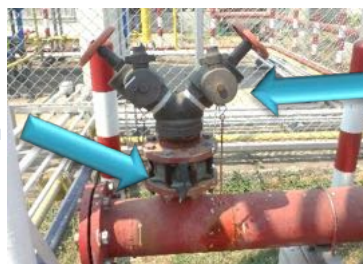
Check Valve ตัวนี้ไม่ต้องติดตั้ง
