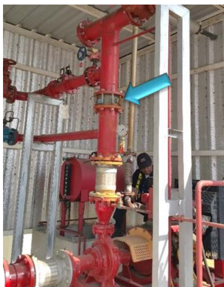
Check Valve ชำรุดปิดน้ำไม่อยู่
