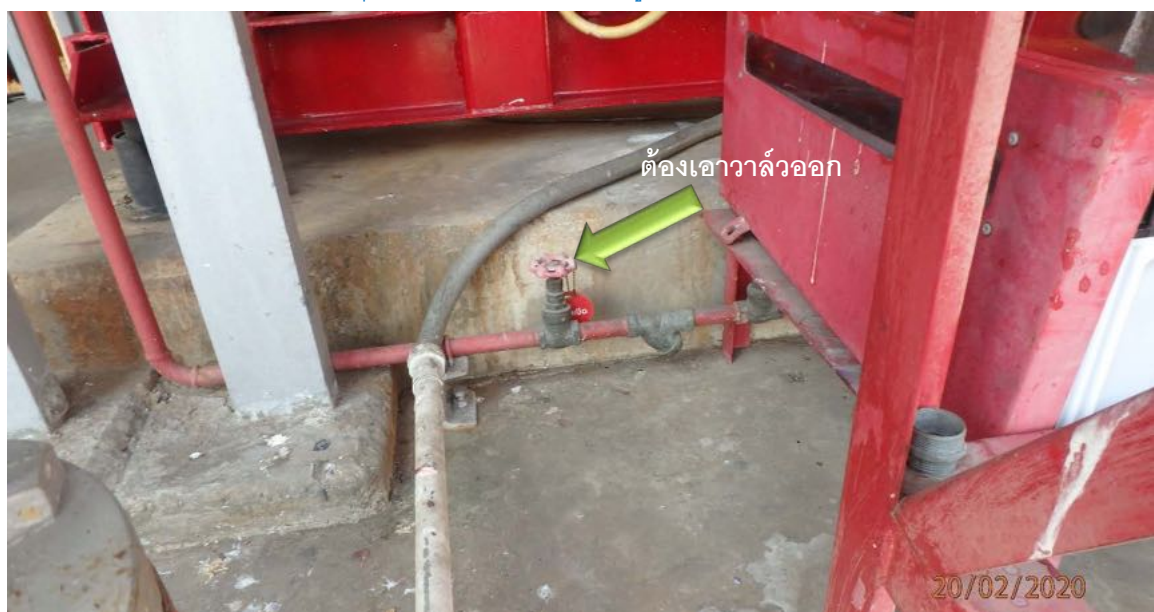
ควรทำจุดยกหัวสำหรับยกท่อทางดูดของปั้มน้ำขึ้นมาซ่อม
