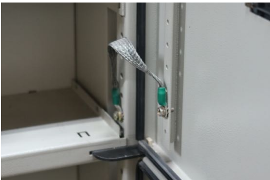
ตรวจสอบสายกราวด์ฝากฟาส์
