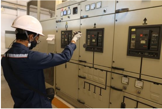
ตรวจสอบค่าความเข้มของแสงบริเวณหน้าตู้
