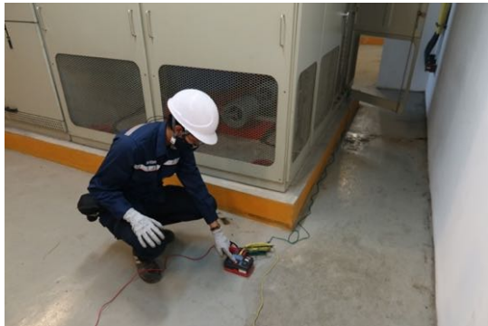
ตรวจสอบค่าความต้านทานลงดิน
