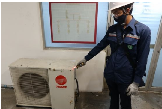
ตรวจสอบกระแสไฟฟ้าวของคอมเพรสเซอร์
