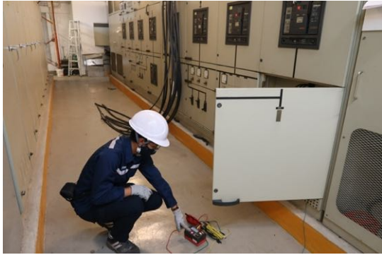
ตรวจวัดค่าความต้านทานการต่อลงดิน
