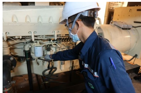
ตรวจสอบน้ำมันเครื่อง
