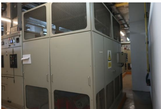
การตรวจสอบหม้อแปลง TR1 ขนาด 2000 kVA
