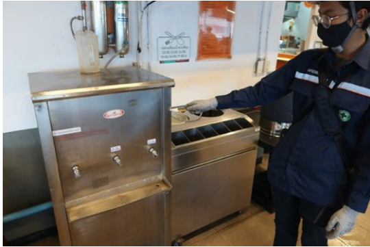
ตรวจสอบกระแสไฟฟ้าวของตู้กดน้ำดื่ม
