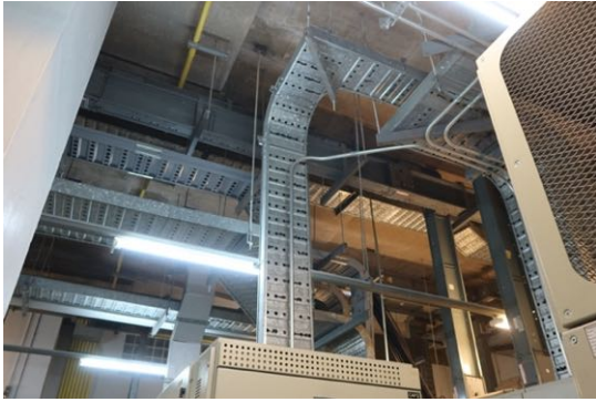
ลักษณะการเดินสายแรงต่ำผ่านรางเคเบิล (cable)
