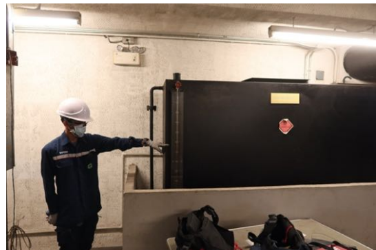
ตรวจสอบระดับน้ำมันเชื้อเพลิง
