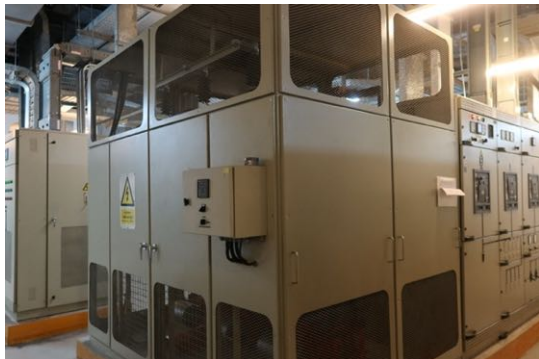
การตรวจสอบหม้อแปลง TR2 ขนาด 2000 kVA
