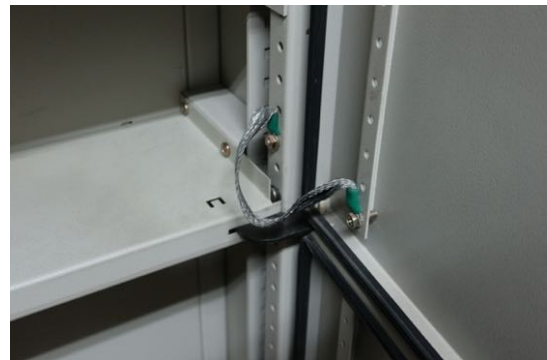
ตรวจสอบสายกราวด์ฝากฟ้าตู้
