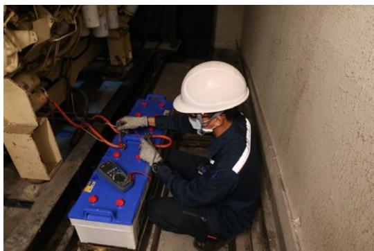
ตรวจสอบแรงดันแบตเตอรี่
