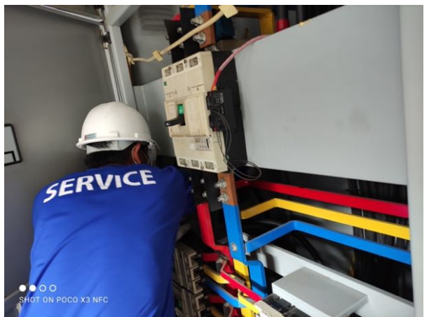
ภาพใช้ผ้าสะอาดทำความสะอาดบริเวณในตู้
