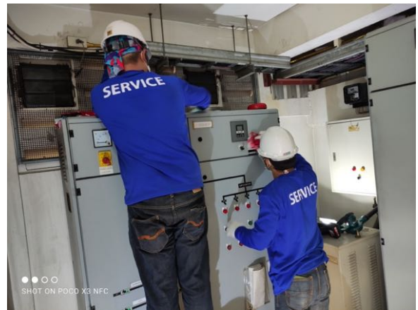
ภาพใช้ผ้าสะอาดทำความสะอาดบริเวณฝาตู้
