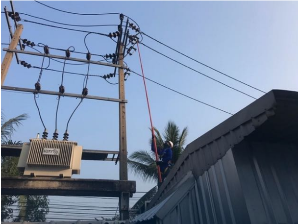
ภาพการชักครอปฟิวส์ของหม้อแปลง 500 KVAR
