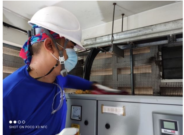
ภาพใช้ผ้าสะอาดทำความสะอาดจากด้านบนตู้
