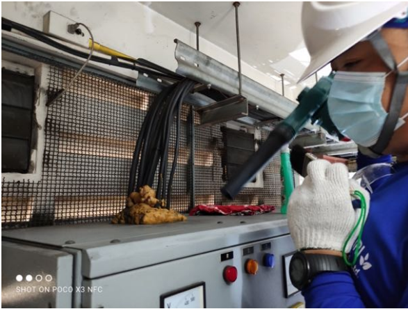
ภาพทำความสะอาดด้วย BLOWER บริเวณฝาหลังตู้
