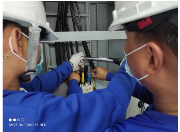
ภาพ Retighten จุดต่อสาย
