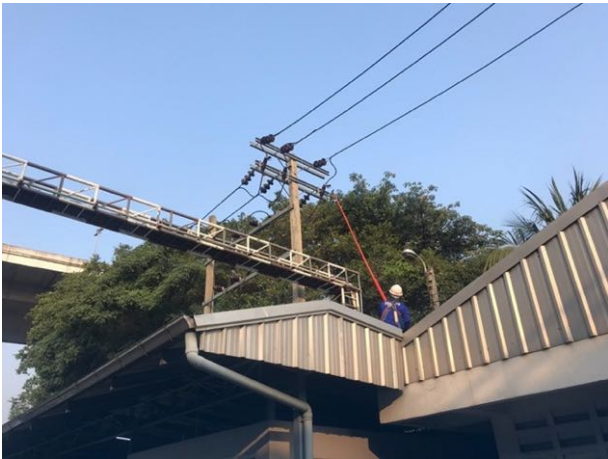
ภาพการชักครอปฟิวส์ของหม้อแปลง 160 kVAR
