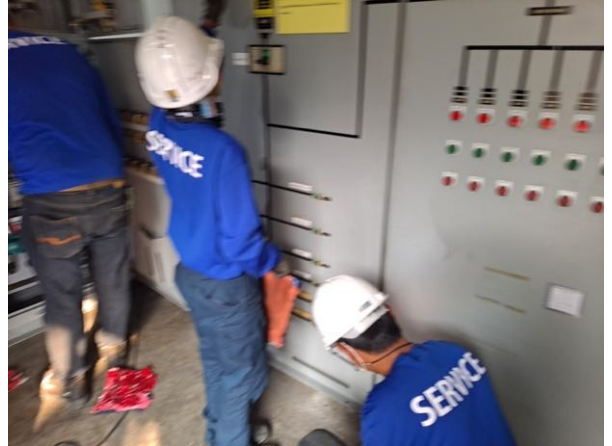
ภาพใช้ผ้าสะอาดทำความสะอาดบริเวณแผงตู้
