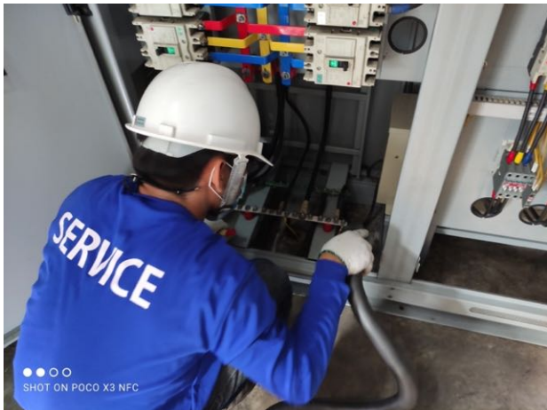
ภาพทำความสะอาดด้วย BLOWER บริเวณด้านในตู้
